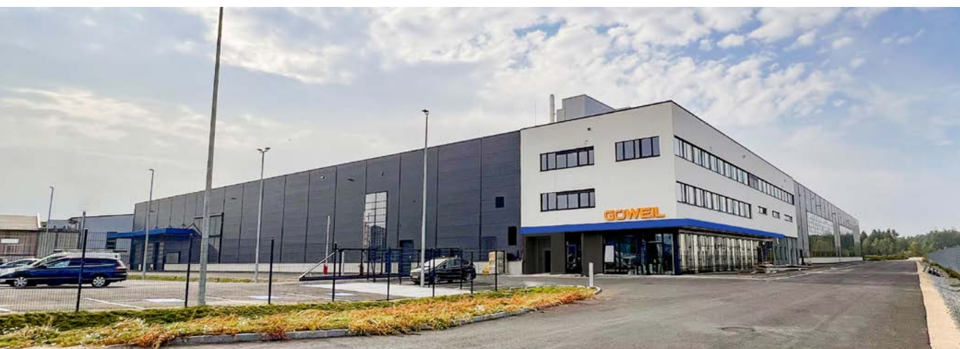
Anläggningar i Kirchschlag (ovan) och Rainbach (nedan)
