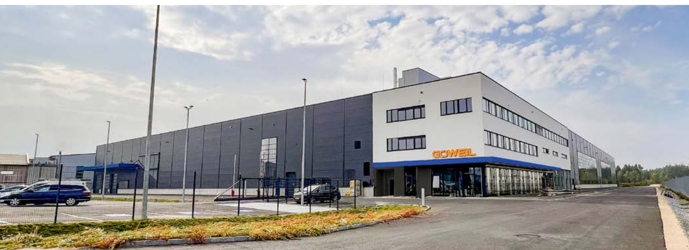
Anläggningar i Kirchschlag (ovan) och Rainbach (nedan)
